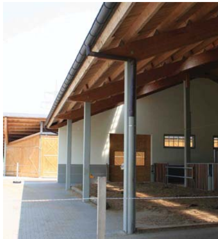
Einer der beiden Offenstallbereiche wurde bereits letzten Winter fertig gestellt (links). Für die zweite Gruppe werden die Erfahrungen des Winters umgesetzt – so wird das Dach weiter herausgezogen, um mehr Wetterschutz zu gewährleisten (rechts).
